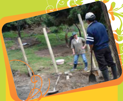
Construcción de cuyera en el predio de Ana Lucía Caez
