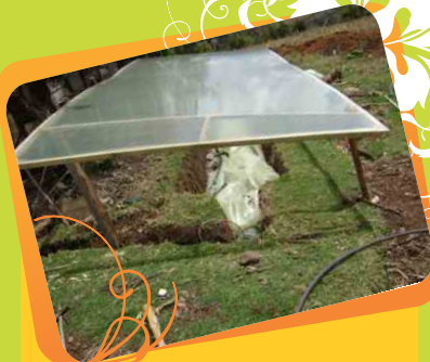
Marranera y biodigestor terminados en el predio de Fredy Chávez.
