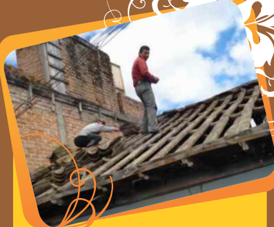
Trabajo de adecuación en el CADI.
