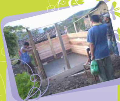
Familia y vecinos colaboran en la implementación de la marranera y biodigestor.
